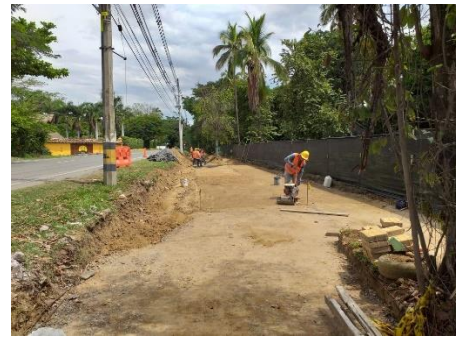
INVERSIONESSIRO, VACIADO DE ESTRUCTURA
