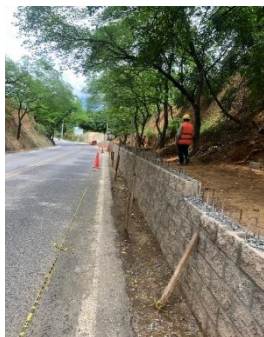
CONEXIÓN OC1-OC3, CONSTRUCCION DE FILTRO MURO DE CONTENCIÓN
