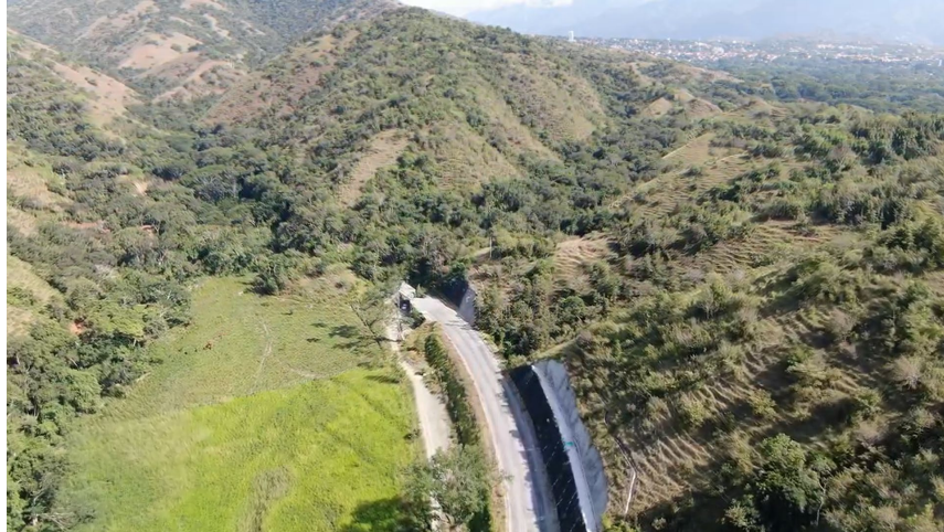
Fuente: Gerencia Túnel del Toyo
