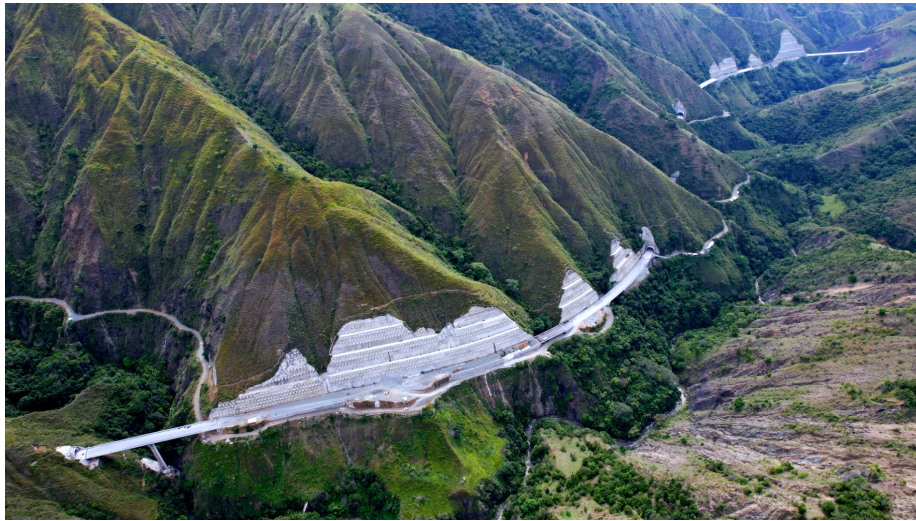
Frente de Trabajo 4, Túnel del Toyo. Occidente, Municipio de Giraldo. Fuente: Gerencia Túnel del Toyo.
