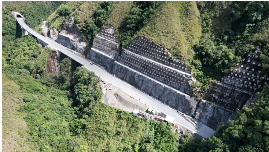
Fuente: Gerencia Túnel del Toyo.
