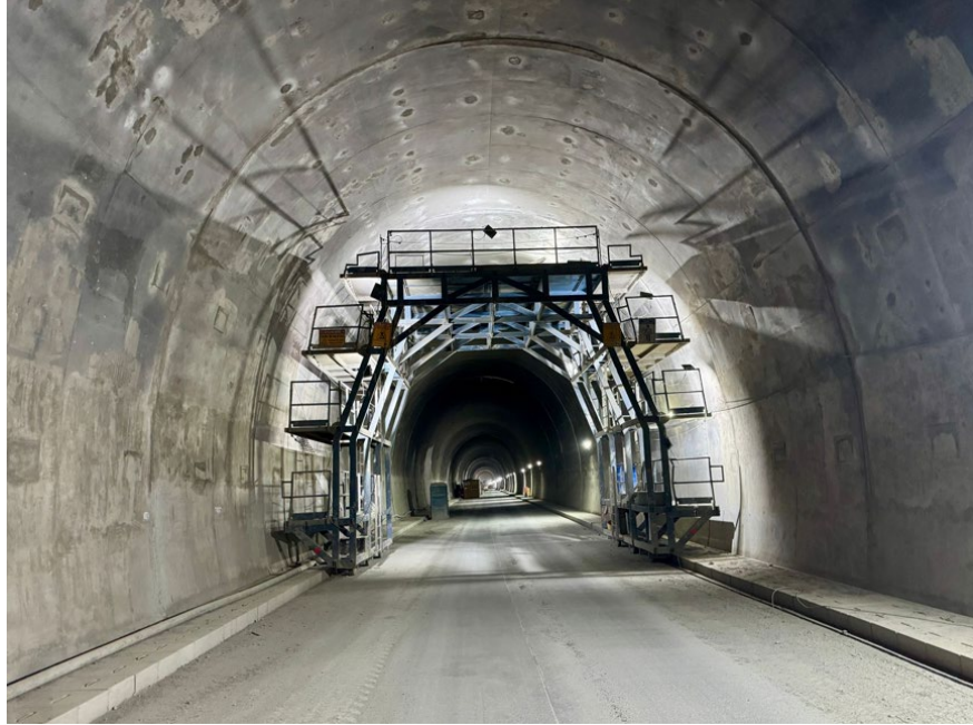
Fuente: Gerencia Túnel del Toyo.
