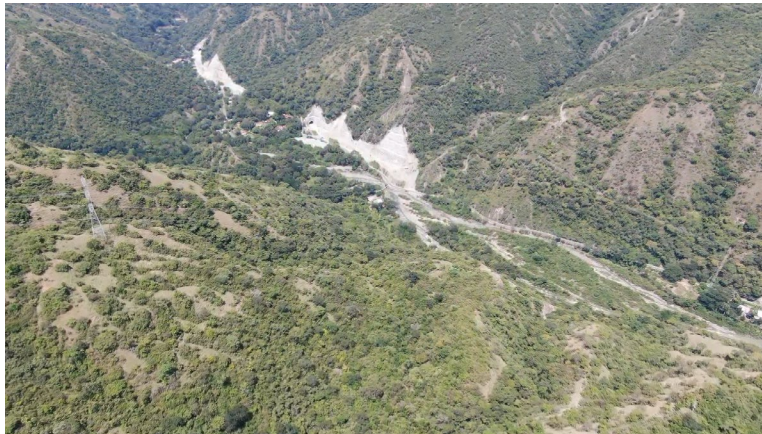
Fuente: Gerencia Túnel del Toyo
