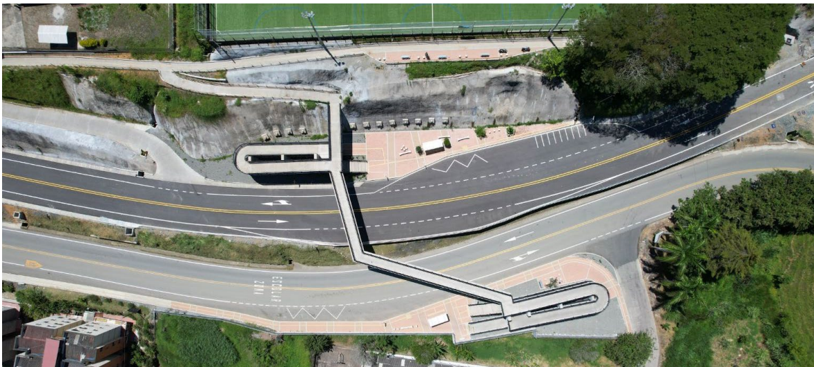
Fuente: Gerencia Túnel del Toyo.
