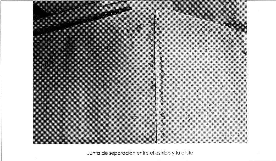
De igual forma en el numeral 11.6.1.6 (juntas de expansion y retención), de la Norma, no aplica, debido a las longitudes de los estribos y las aletas del puente y del semiviaducto, son menores a las recomendaciones de aplicación de las juntas de expansion y retencion solicitadas.
