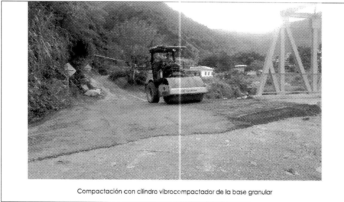
Compactación con cilindro vibrocompactador de la base granular
