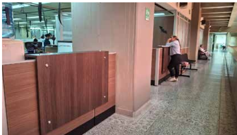
Registro fotográfico 7: Atención remodelada en piso dos costado sur con alturas superiores a las permitidas por accesibilidad según NTC6047 para la atención de usuarios internos y externo.
