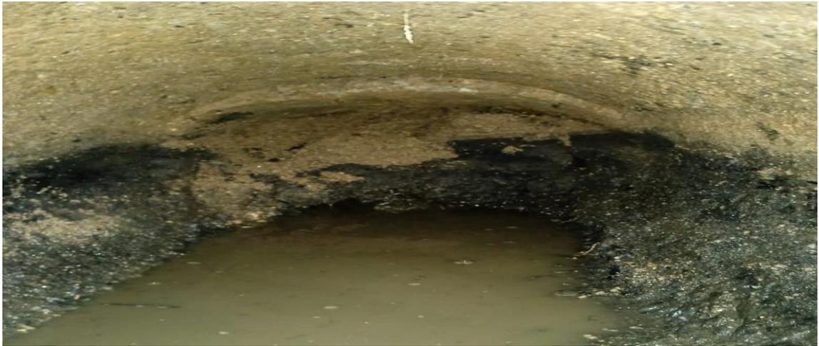
Fotografía 3. Estado de las obras transversales, se evidencia escalonamiento de la tubería
