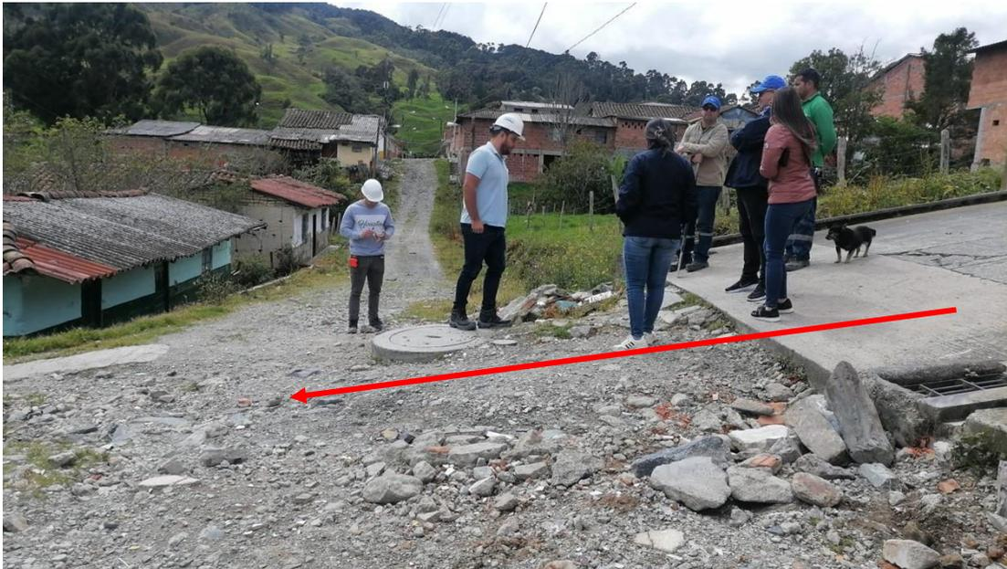
FOTO 15. En la imagen se logra observar la necesidad de hacer empalmes de la calle 19 (vía a intervenir) con la carrera 19 vía que no cuenta con unas buenas condiciones y que se hace necesario mejorar con empalmes en concreto para evitar daños a la infraestructura a construir, en este caso a la calle 19.
