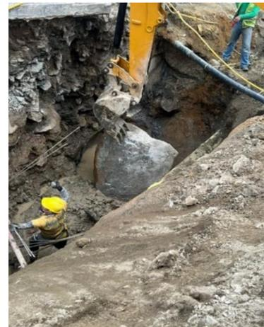
FOTO18 Es necesaria realizar demoliciones en roca con cemento expansivo
