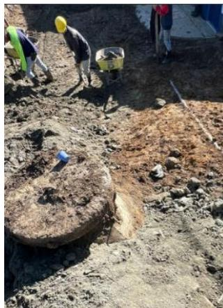
FOTO17. En la red de alcantarillado se deben bajar los niveles de los cuellos de los manholes, la tubería de alcantarillado se deja como esta en la actualidad
