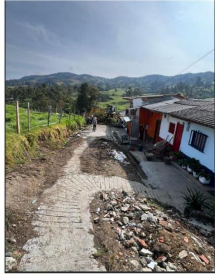
FOTOS 13-14. En la imagen se puede observar la diferencia de niveles entre las viviendas, situación que obliga a replantear los niveles y alineamiento horizontal, con el fin de proteger la infraestructura y evitar inundaciones por su ubicación de des favorabilidad.
