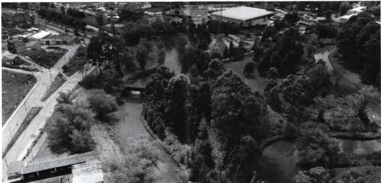
Imagen # 1. Estado actual, ámbito patrimonial. Proyecto: Paisajes del Agua.
