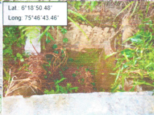
Encoles en estado regular- vegetación Fuente: Elaboración propia
