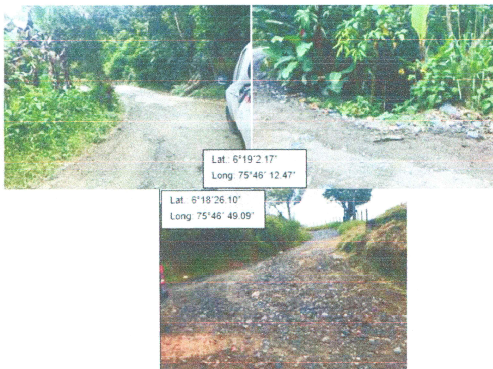
Estado de la vía existente húmeda en mal estado. Fuente: Elaboración propia
