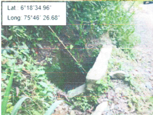
Encoles en estado regular- vegetación Fuente: Elaboración propia
