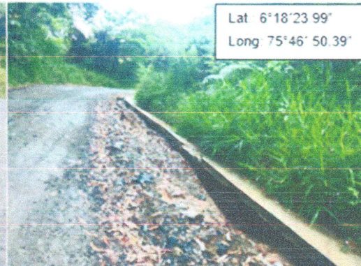
Encoles en estado regular- vegetación Fuente: Elaboración propia
