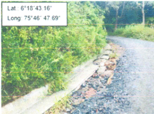
Encoles en estado regular- vegetación Fuente: Elaboración propia
