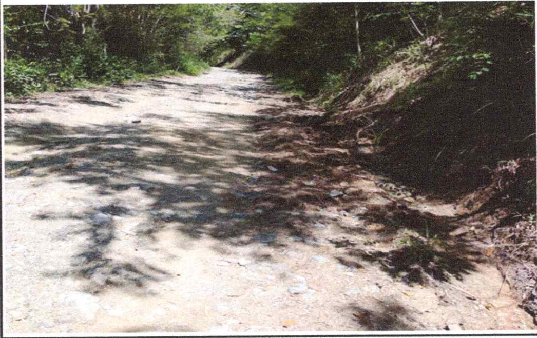
Superficie de rodadura en malas condiciones debido al mal manejo de aguas.
