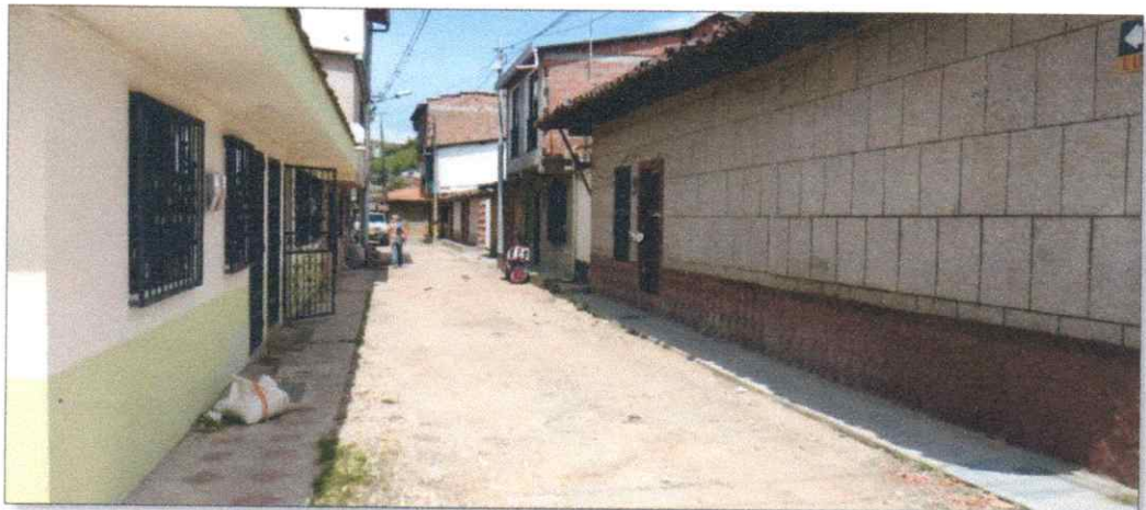
Estado actual de las vías urbanas
