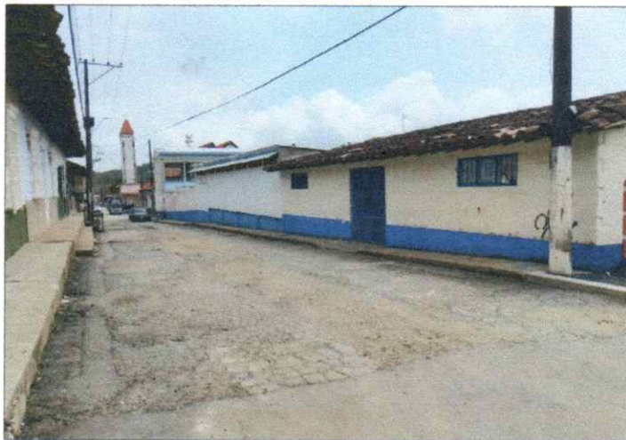
Estado actual de las vías urbanas
