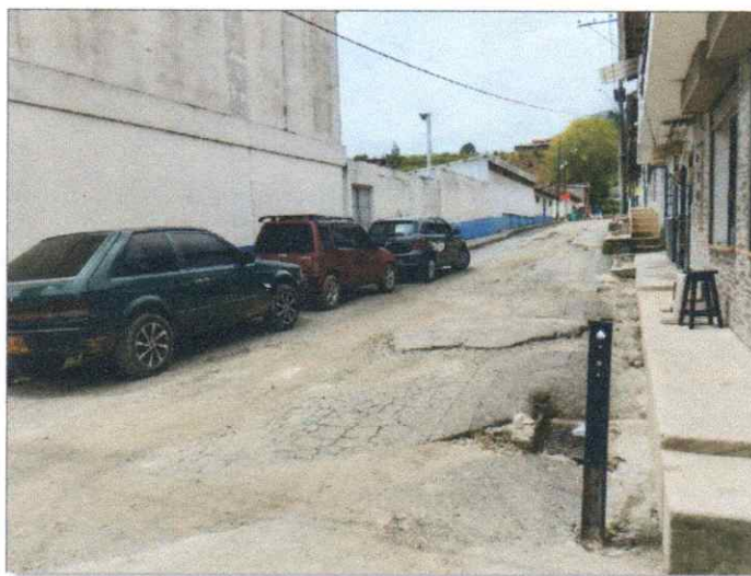
Estado actual de las vías urbanas
