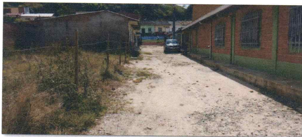
Estado actual de las vías urbanas
