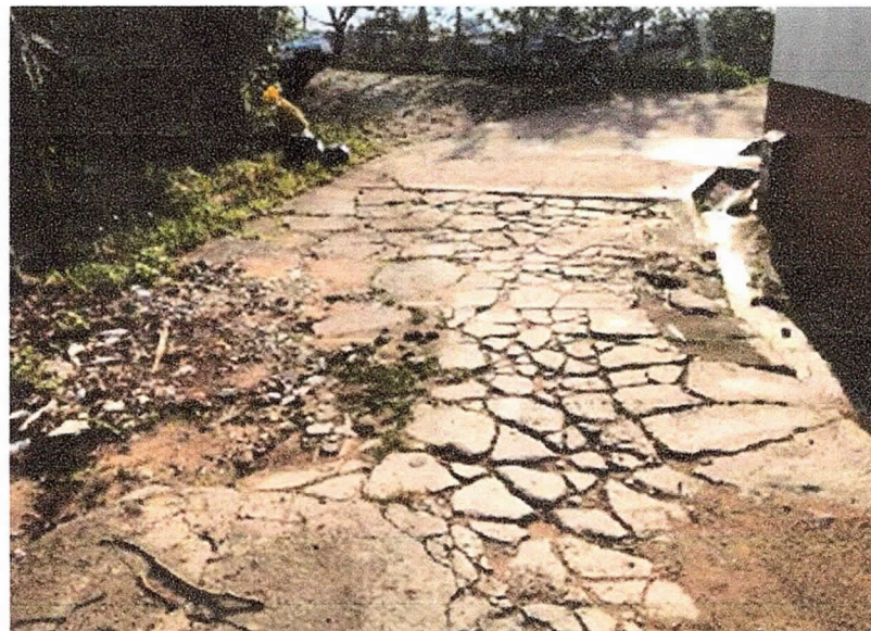
Imagen 7 – Fotografía estado actual vía Beneficiencia parte baja
