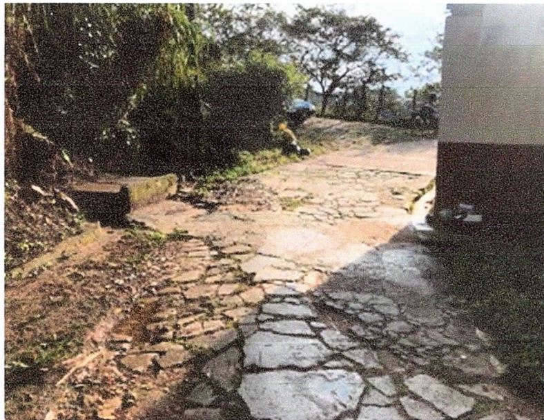
Imagen 9 – Fotografía estado actual vía Beneficiencia parte baja
