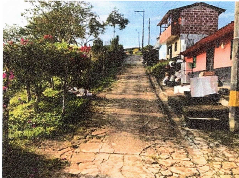
Imagen 6 – Fotografía estado actual vía Beneficiencia parte baja
