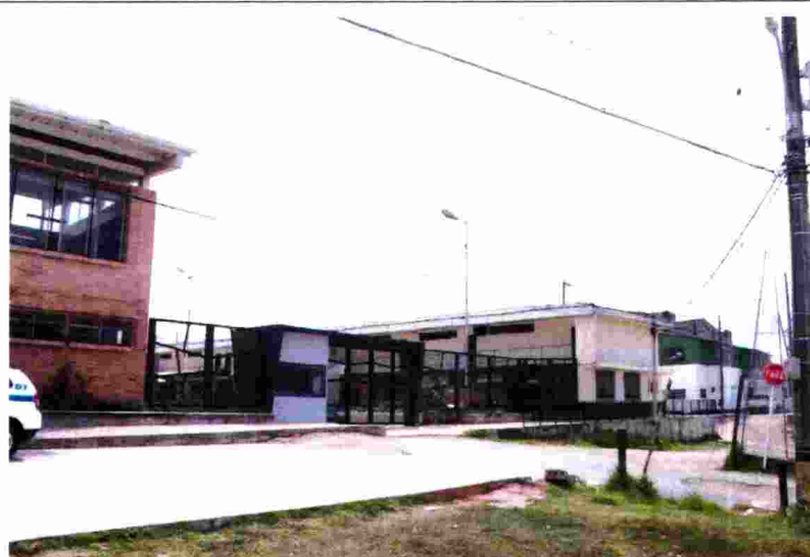
Nº Fachada de I.E. CAMD Sede Principal 1 sobre la Cll 26 con Cra 35
