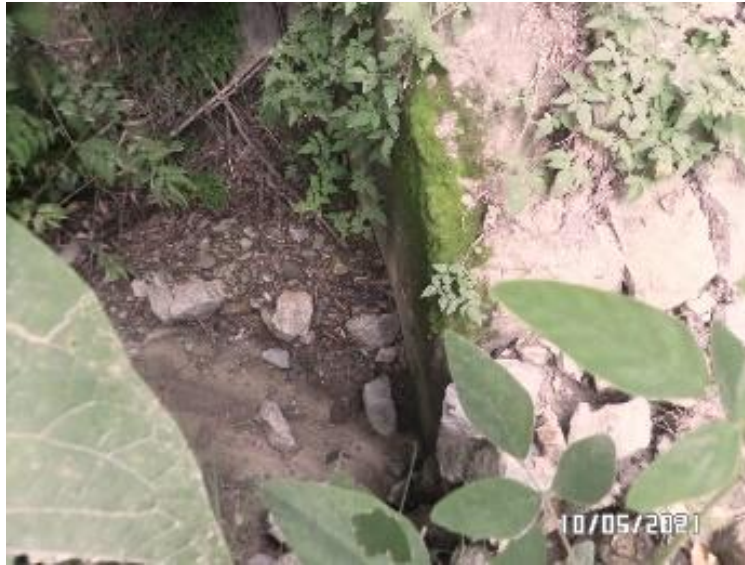
Figura 3. Descole de la obra.
