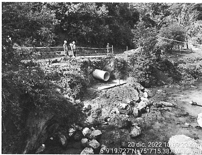
Foto 4. Obra de drenaje ubicada en el k13+097, vista desde el puente existente.
