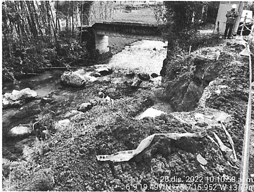
Foto 5. Obra de drenaje ubicada en el k13+097, vista desde la vía.
