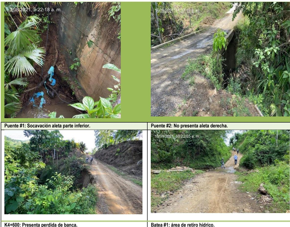
Puente #1: Socavación aleta parte inferior.
