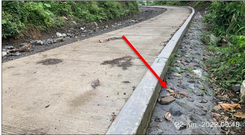
Fotografía 7: Construcción de **protección lateral concreto ciclópeo** (Carepa – Campamento).
