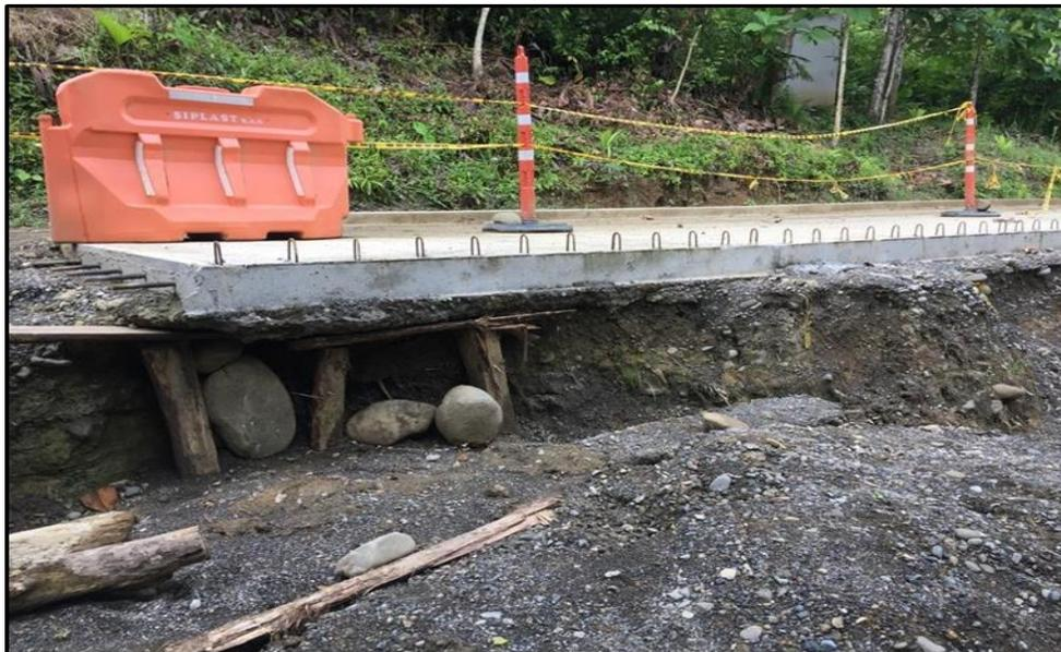
**Fotografía 1** Perdida de banca por movimiento de talud.
