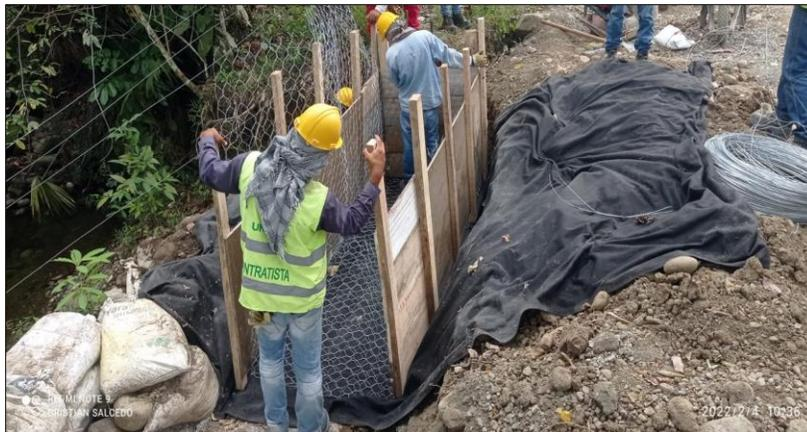
Fotografía 2: Construcción de gaviones tipo 1 (Carepa – Polines)
