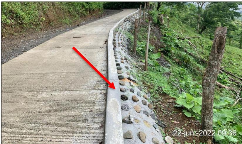
Fotografía 9: Construcción de **protección lateral concreto ciclópeo** (Carepa – Campamento).
