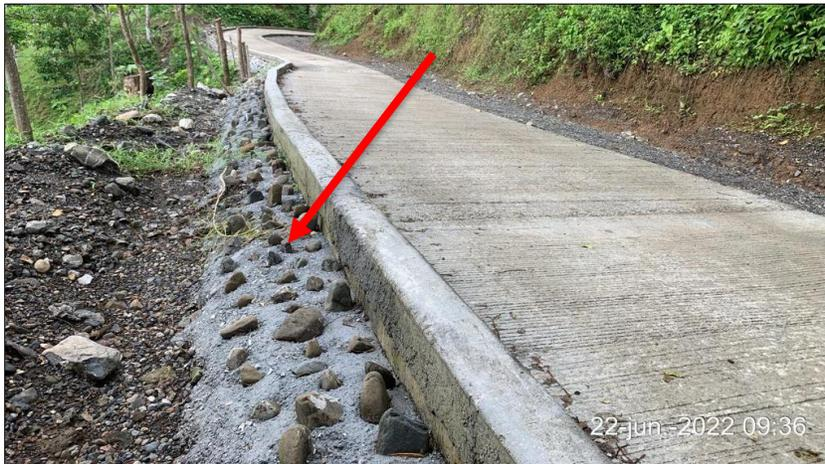
Fotografía 8: Construcción de **protección lateral concreto ciclópeo** (Carepa – Campamento).
