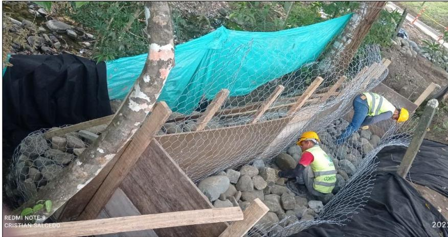
Fotografía 4: Construcción de gaviones tipo 2 (2x1) (Carepa – Polines)
