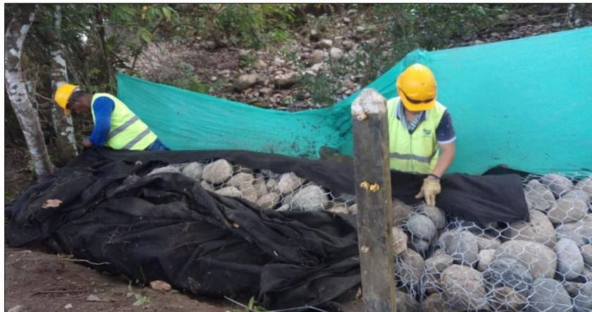
Fotografía 5: Construcción de gaviones tipo 2 (2x1) (Carepa – Polines)
