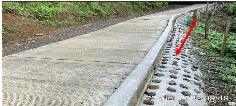
Fotografía 1: Imagen de referencia de protección lateral en concreto ciclópeo
