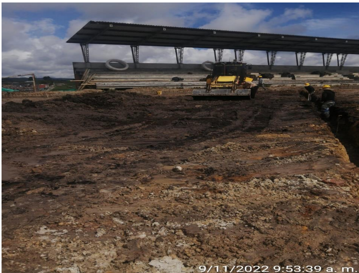
Foto 9. Conformación de tramo de filtro. Se observa el material encontrado durante las excavaciones.
