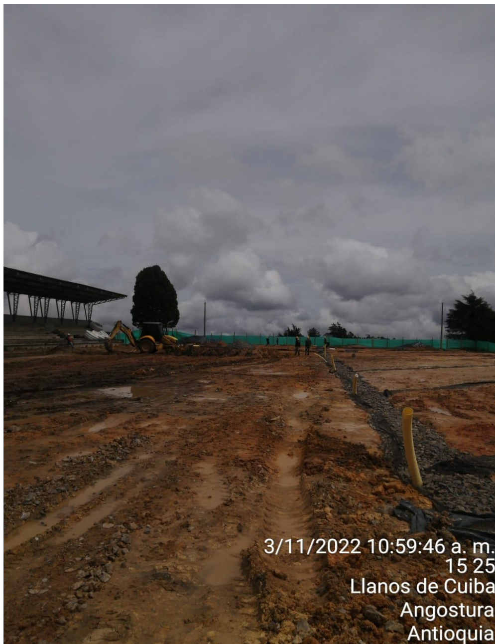
Foto 6. Acarreo de materiales para los concretos
