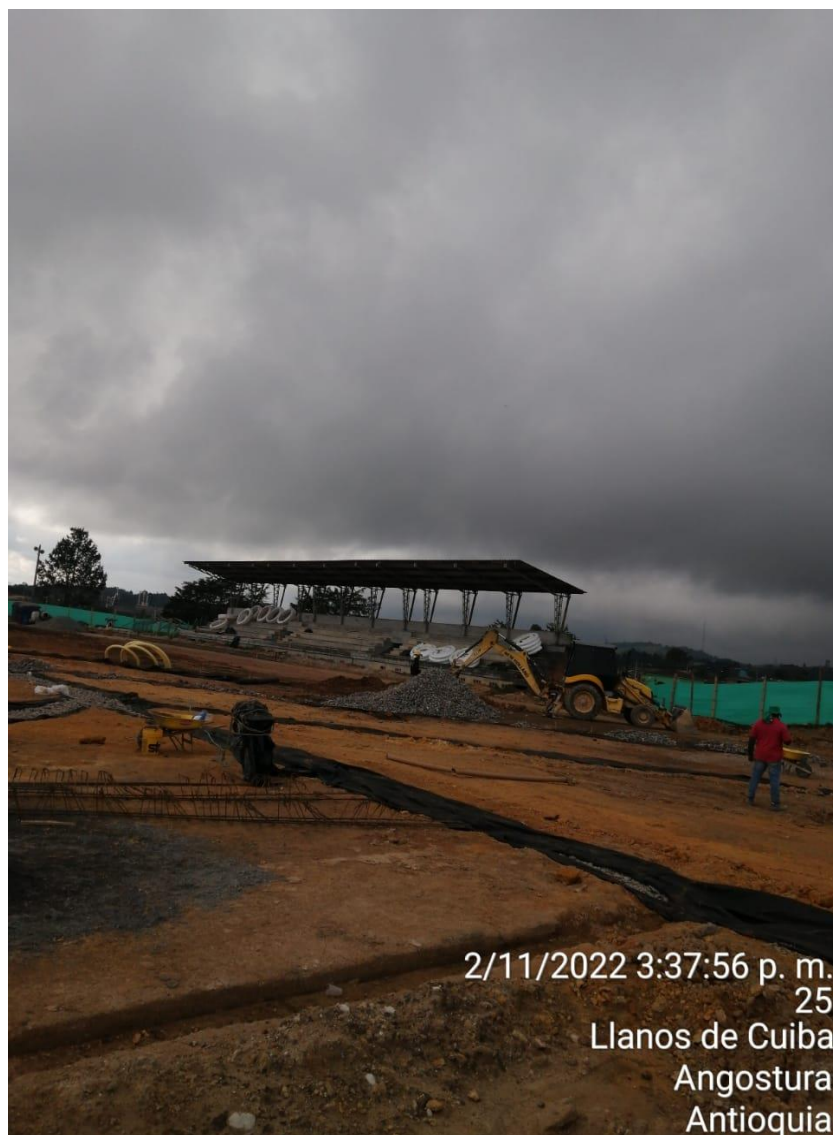
Foto 1. Estado de la zona de trabajos
