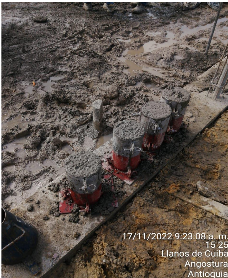
Foto 14. Toma de asentamiento para concretos en obra
