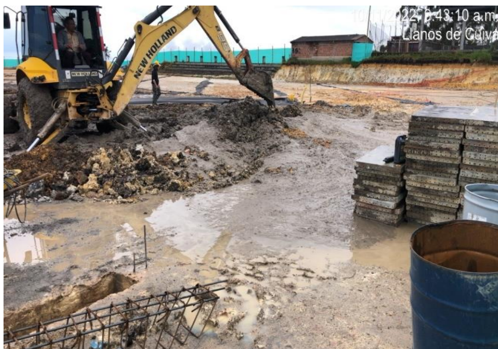
Foto 18. Actividades de excavaciones y llenos
