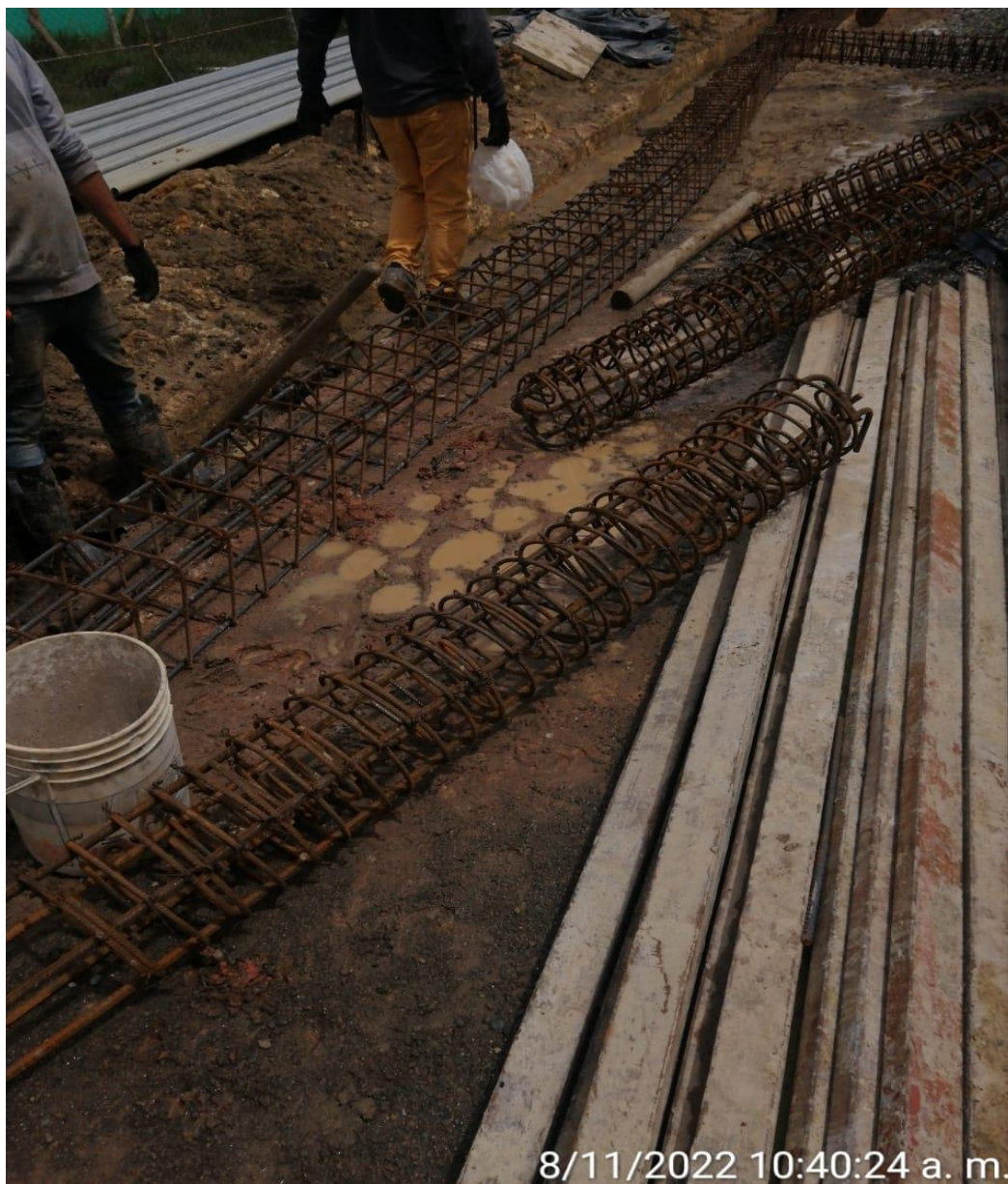
Foto 12. Acero para construcción de viga de cimentación del cerramiento perimetral.
