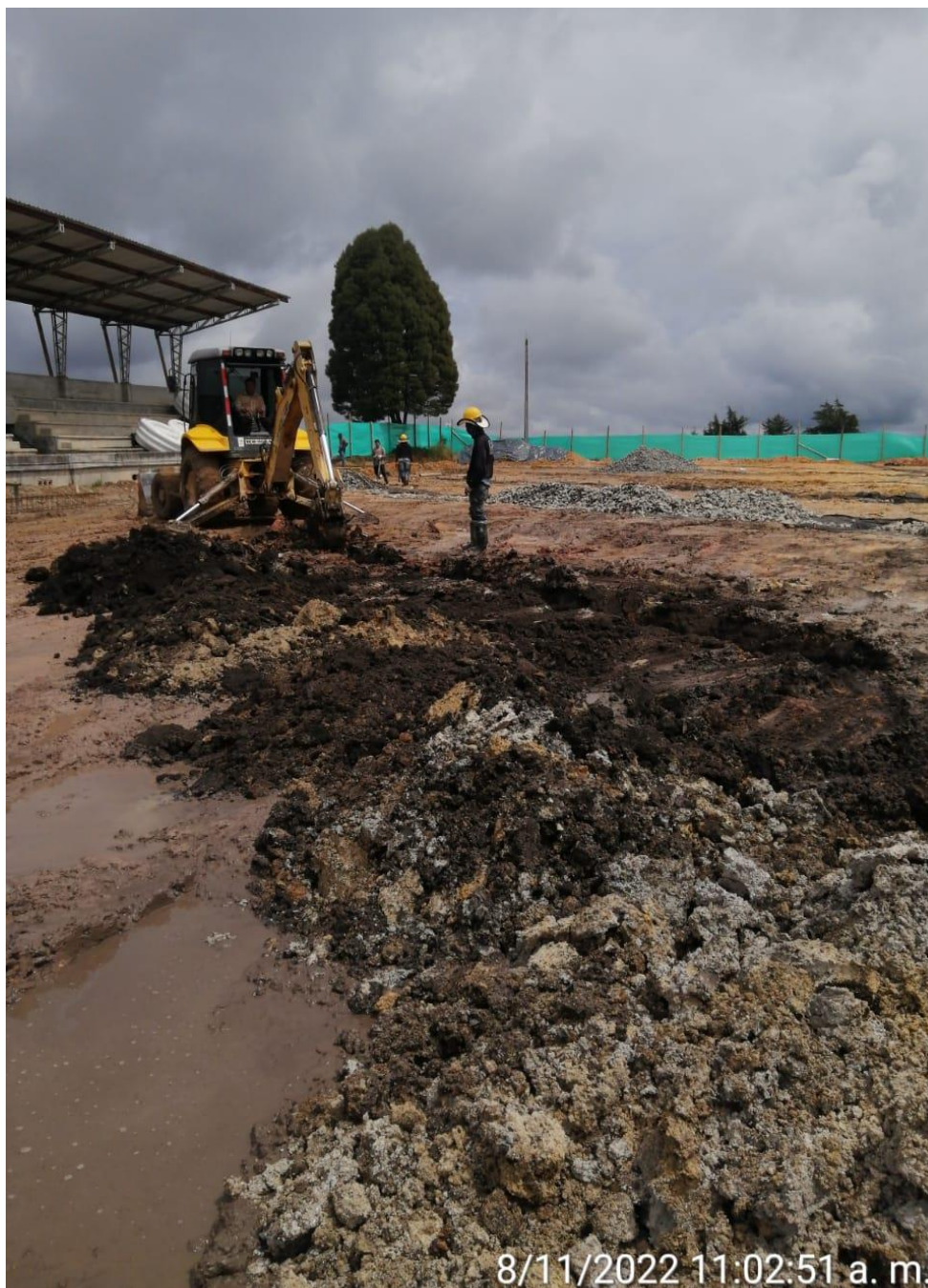
Foto 11. Conformación de tramo de filtro. Se observa el material encontrado durante las excavaciones
