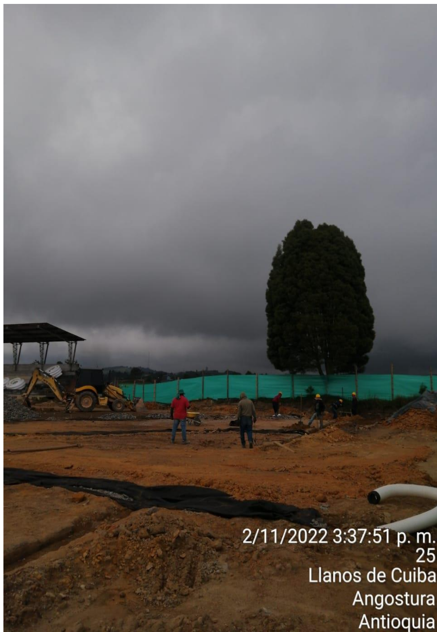
Foto 4. Acarreo de materiales para los concretos
