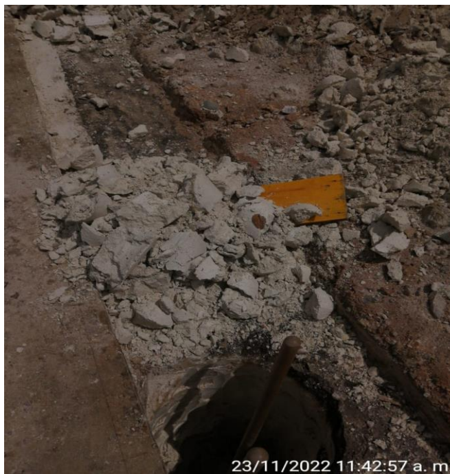
Foto 16. Actividades de excavación para la viga de cimentación del cerramiento perimetral
