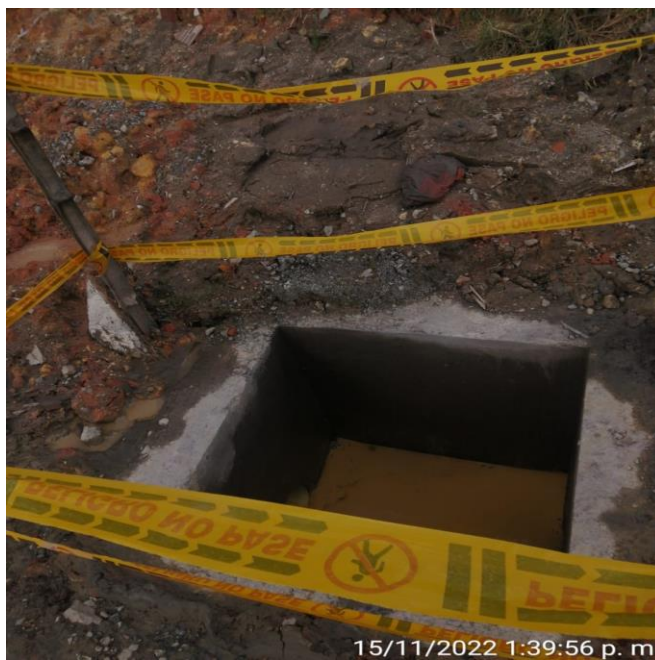
Foto 15. Construcción de caja de empalme
