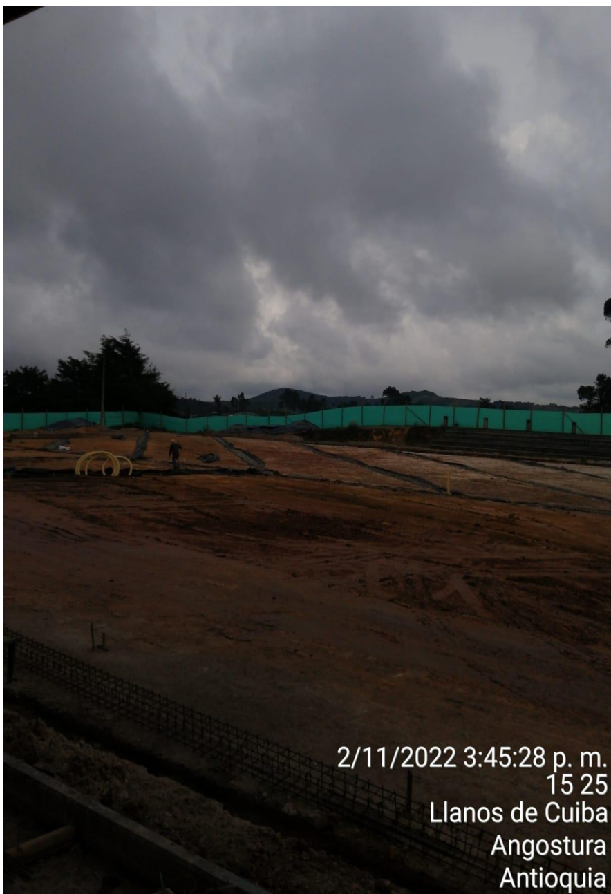
Foto 3. Adecuación de filtros
