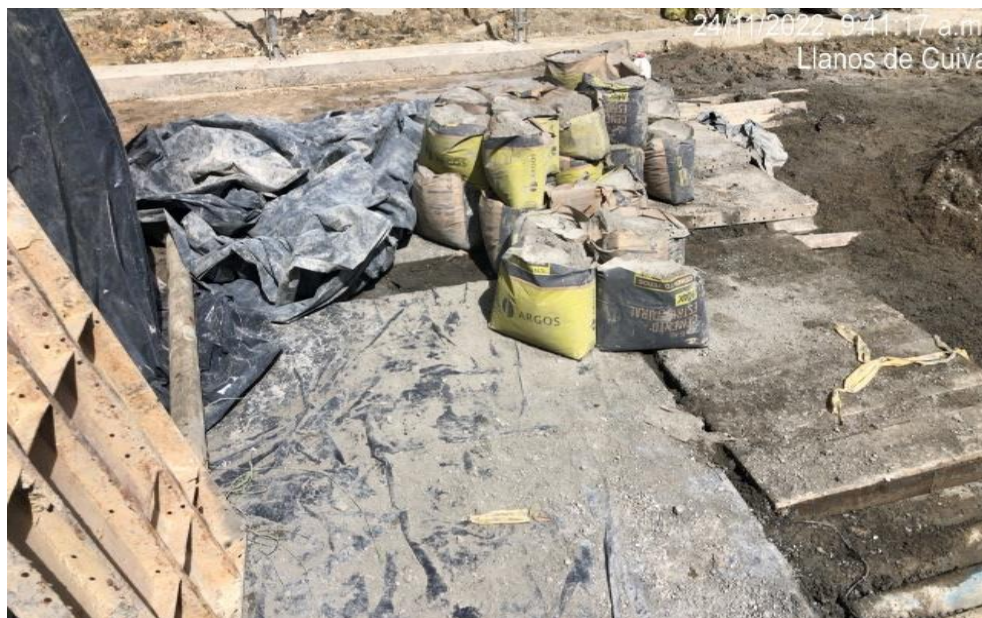
Foto 21. Protección de suelo para la elaboración de concretos
