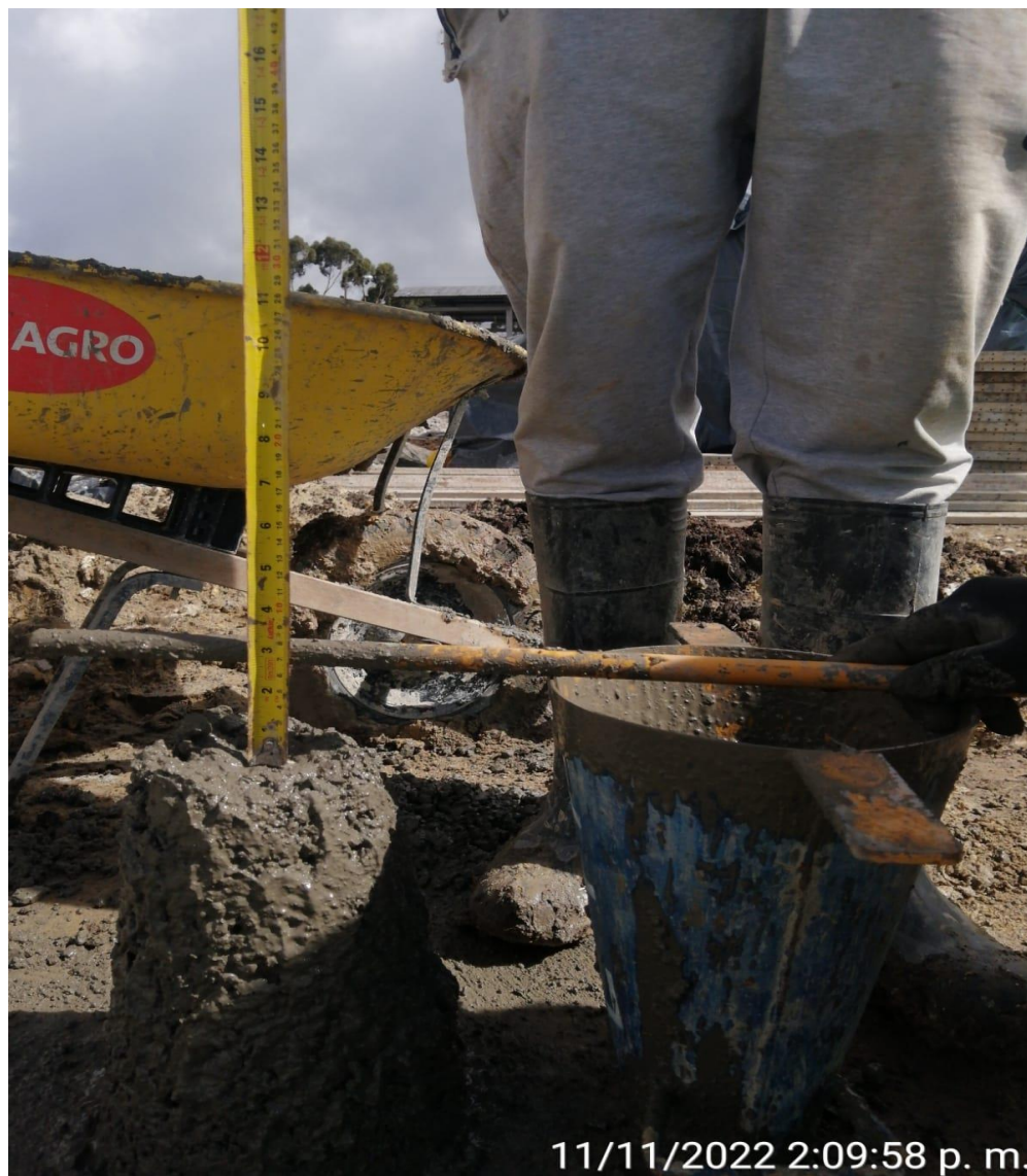
Foto 13. Toma de asentamiento para concretos en obra
