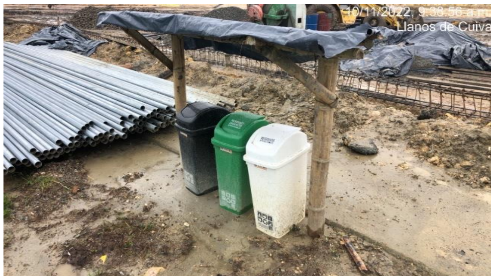
Foto 17. Punto ecológico en obra
