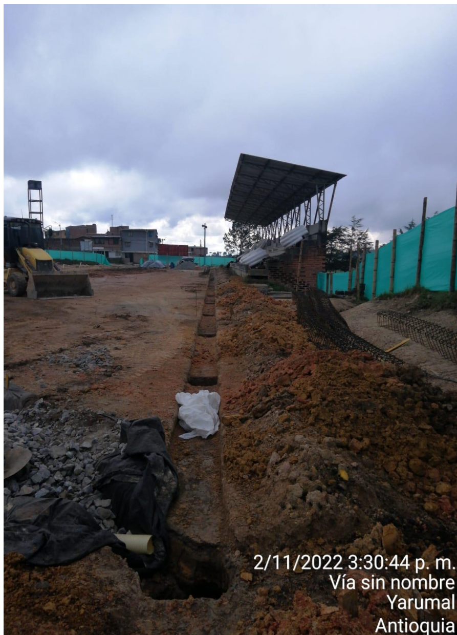
Foto 2. Construcción viga de cerramiento perimetral
