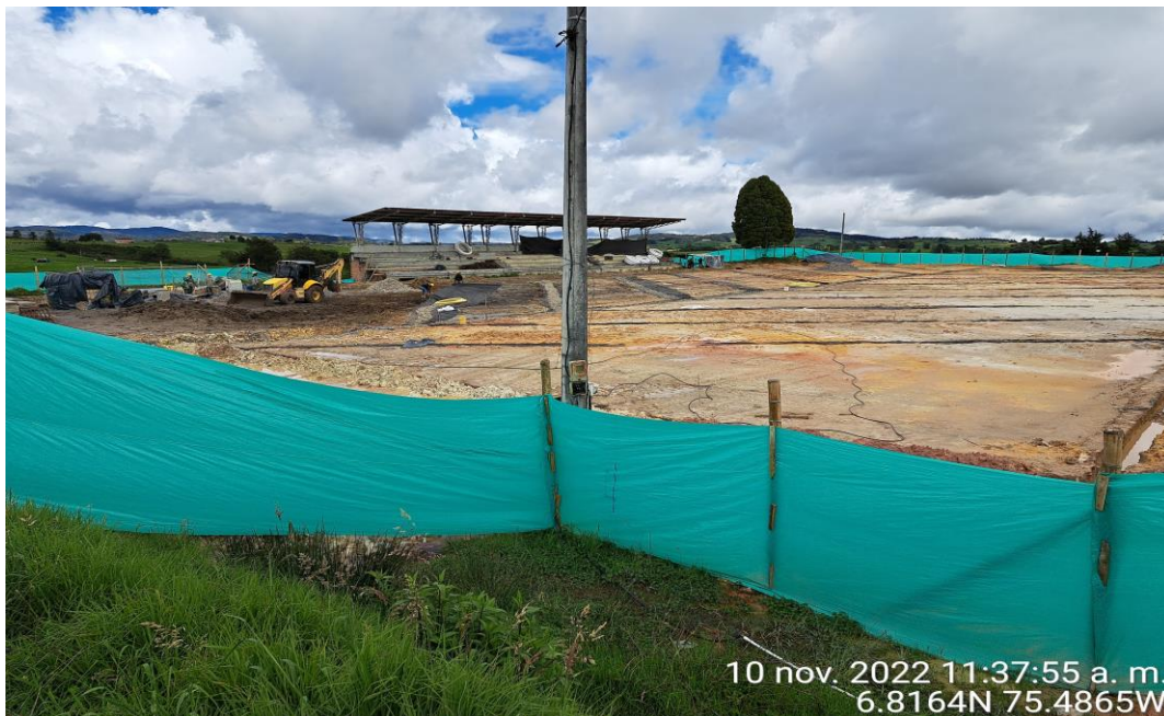
Foto 7. Vista general del avance de obra
