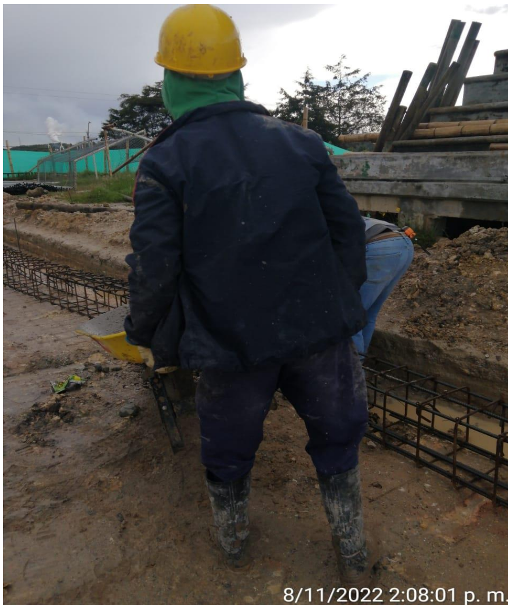
Foto 10. Acero para la construcción de viga de cimentación del cerramiento perimetral
