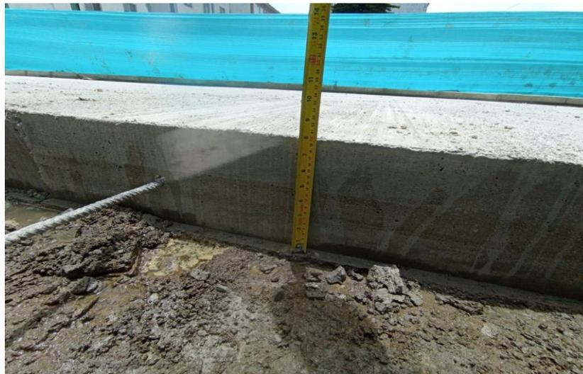
**Ilustración 2.** Espesor de losa (20 cm).
