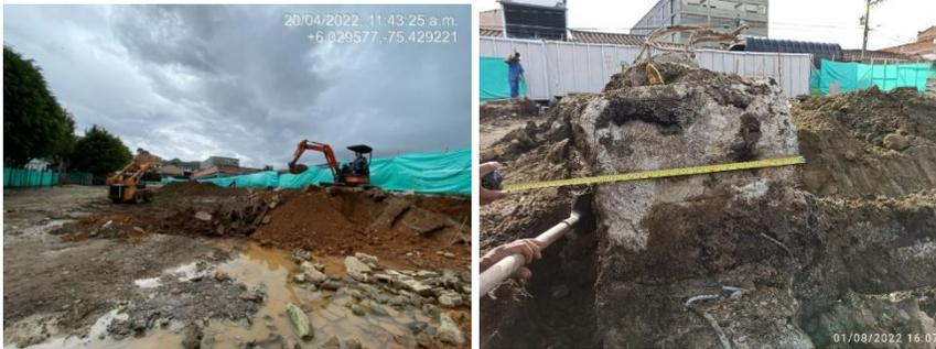
Imagen 1 y 2. subestructuras en concreto existentes
