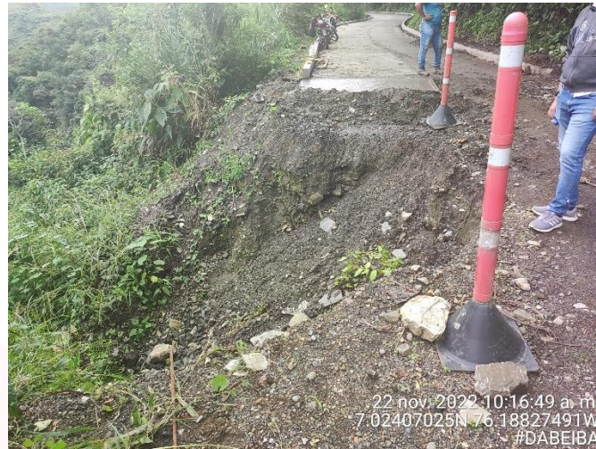
FOTO 2 - ZONA DE INTERVENCION
