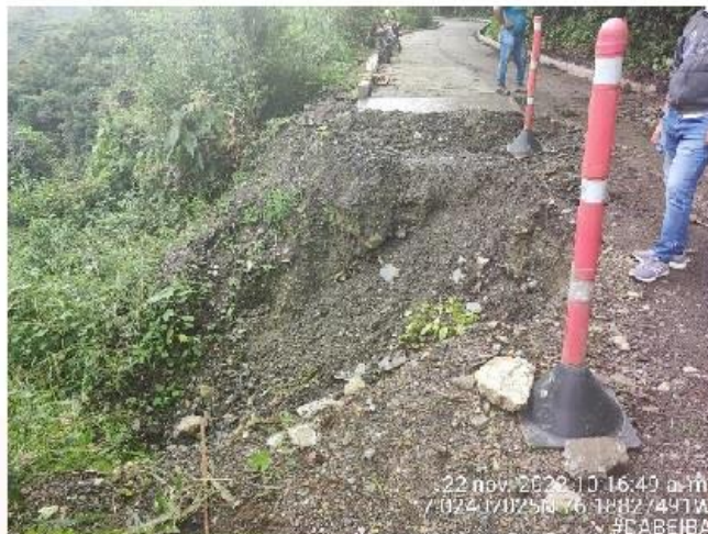
FOTO 2 - ZONA DE INTERVENCION
