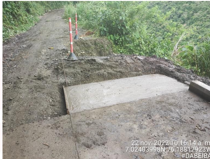
FOTO 1 - ZONA DE INTERVENCION
