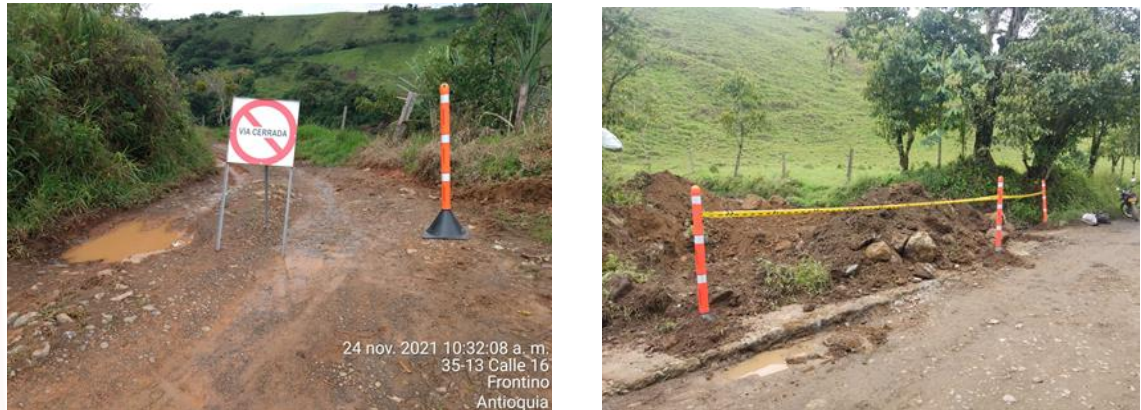
Imagen 1. Cierre de vía – Señalización preventiva e informativa
