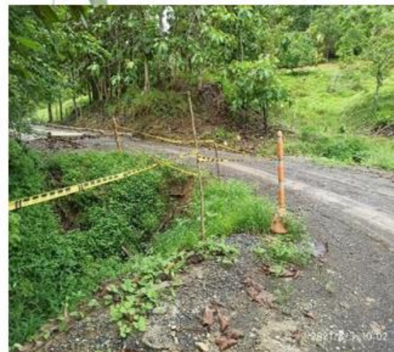
Fotografía 23 Deslizamientos y estado actual del tramo de la vía
