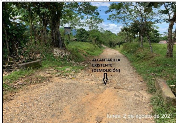
Fotografía 9 Demoliciones de estructuras existentes (Alcantarillas) Remigio - Chigorodó.
