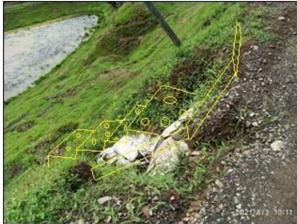
Fotografía 21 Propuesta de aletas y dissipador, municipio de Turbo, Antioquia
