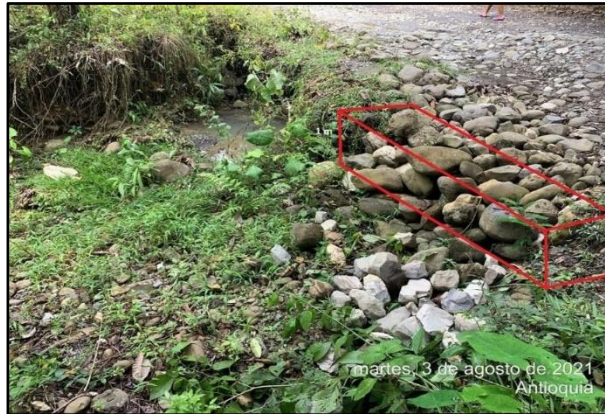
Fotografía 5 Propuesta Gavión 1 (H: 1m, L: 5m, b: 1m). Vía Polines – Carepa
