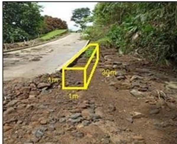
Fotografía 19 Propuesta de gavión municipio de Turbo, Antioquia
