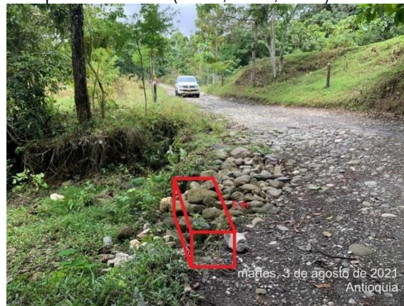
Fotografía 6 Propuesta Gavión 1 (H: 1.0 m, L: 5.0 m, b: 1.0 m). Vía Polines – Carepa
