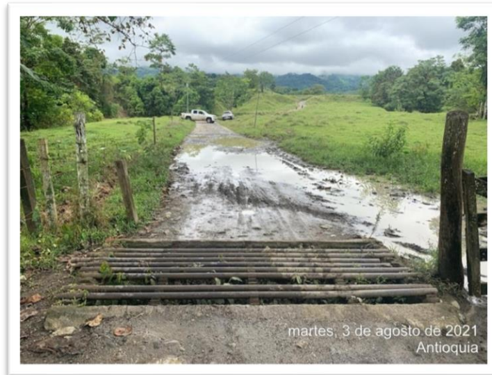
Fotografía 4 Paso canadiense existente.
