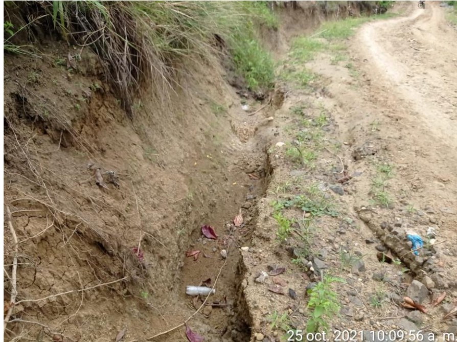
Fotografía 17 Zona crítica de erosión presente en el terreno
