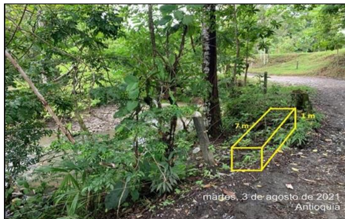
Fotografía 8 Propuesta Gavión 2 (H: 1.0 m, L: 7.0 m, b: 1.0 m). Vía Polines – Carepa
