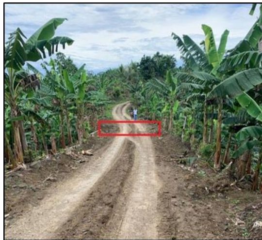
Fotografía 14 Punto de construcción de obra de arte
