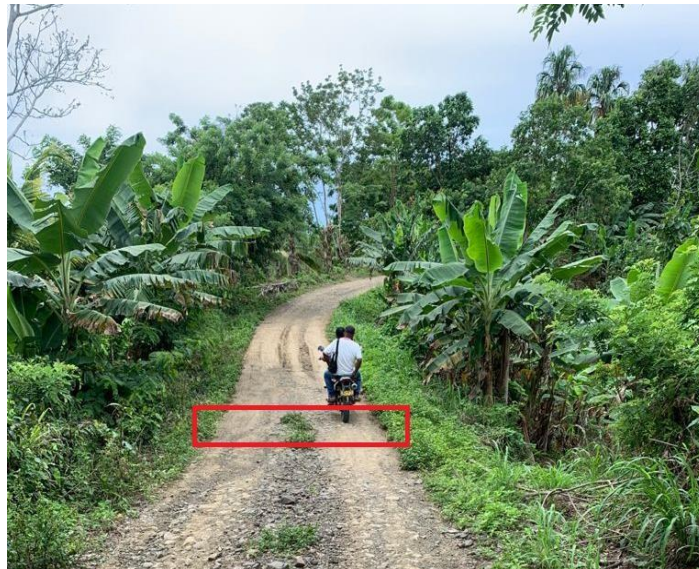
Fotografía 15 Punto de construcción de obra de arte
