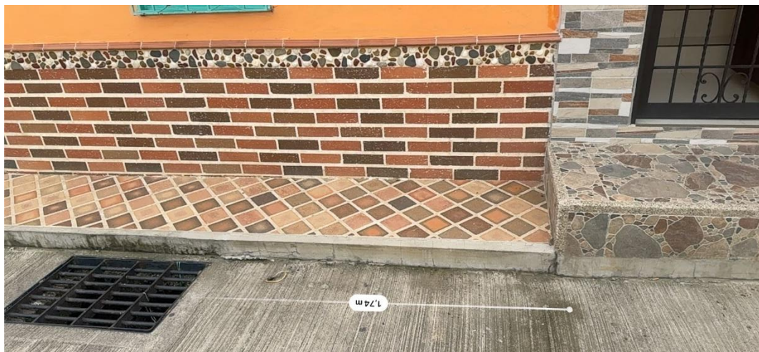
Foto 2. Imágenes año 2024 construcción de sumidero a 1.74 m de sumidero instalado en el año 2014 (Tomado visita de la Secretaría de Planeación y Obras Públicas).
