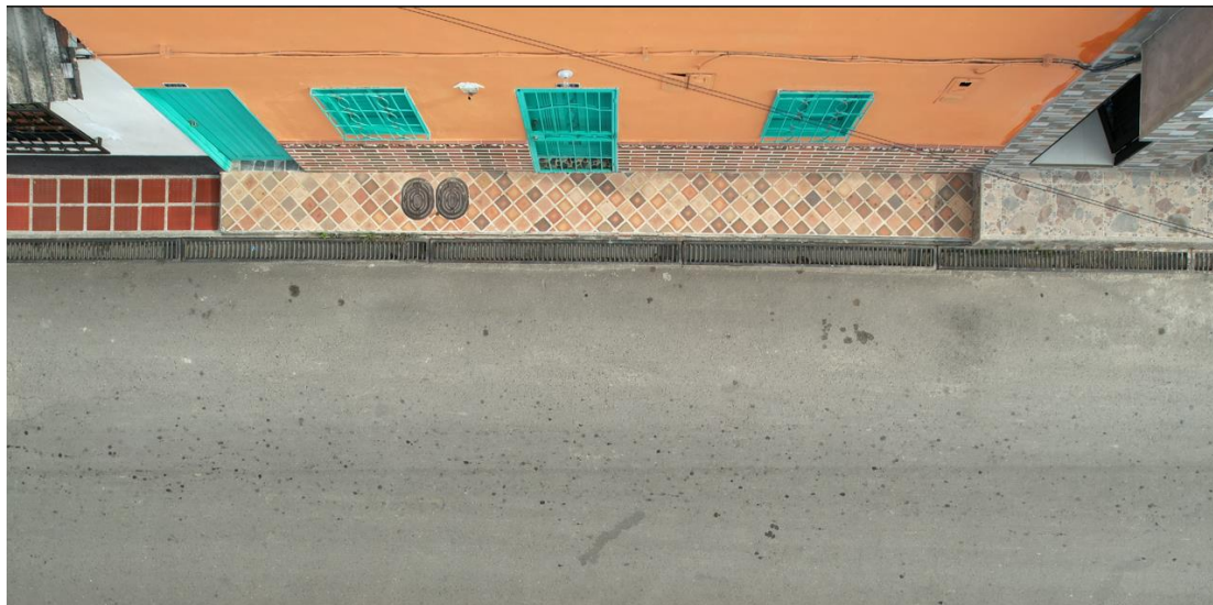
Foto 2. Imagen año 2023 se evidencia cárcamo con rejilla metálica como obra de drenaje de la vía (Tomado carpeta proyecto parque y vías urbanas año 2023, Secretaría de Planeación y Obras Públicas).
