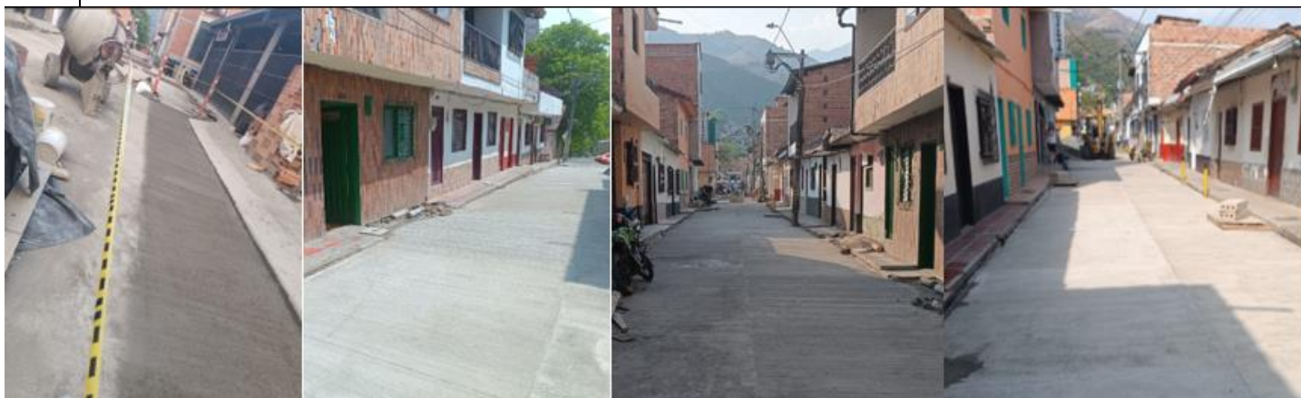
FOTO 8,9,10,11. Diferencia de niveles entre vía y acceso a viviendas
