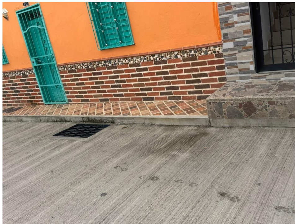
Foto 2. Imagen año 2023 se evidencia cárcamo con rejilla metálica como obra de drenaje de la vía (Tomado carpeta proyecto parque y vías urbanas año 2023, Secretaría de Planeación y Obras Públicas).
