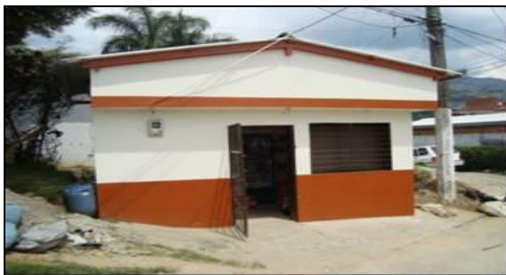
REPARACION DE VIVIENDA
