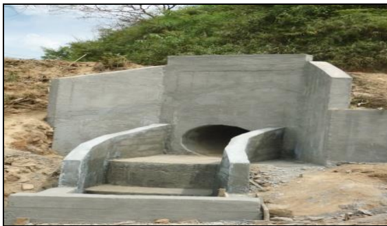
OBRAS EN LA VIA PTO NUEVO Y MISERENGA TERMINADO
