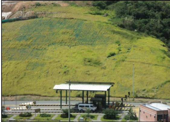
OBRAS DE MITIGACION EN TALUDES Peaje oriental km 9+000
