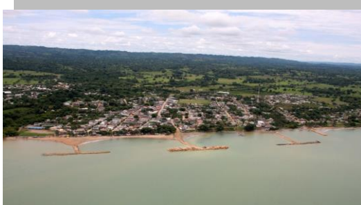
OBRAS DE CONTROL A LA EROSIÓN EN LOS MUNICIPIOS DE TURBO Y ARBOLETES.
