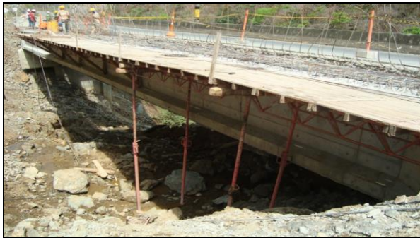
REPARACION PUENTE LA GUAIRA
