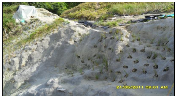
OBRAS DE MITIGACION SALTOS Y PISQUINES
