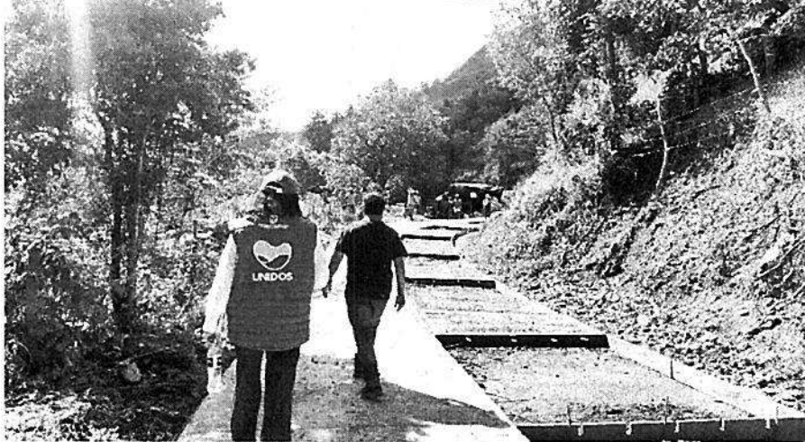
Municipio de Giraldo, recorrido sobre la ejecución de vaciado alternado en placas MR
