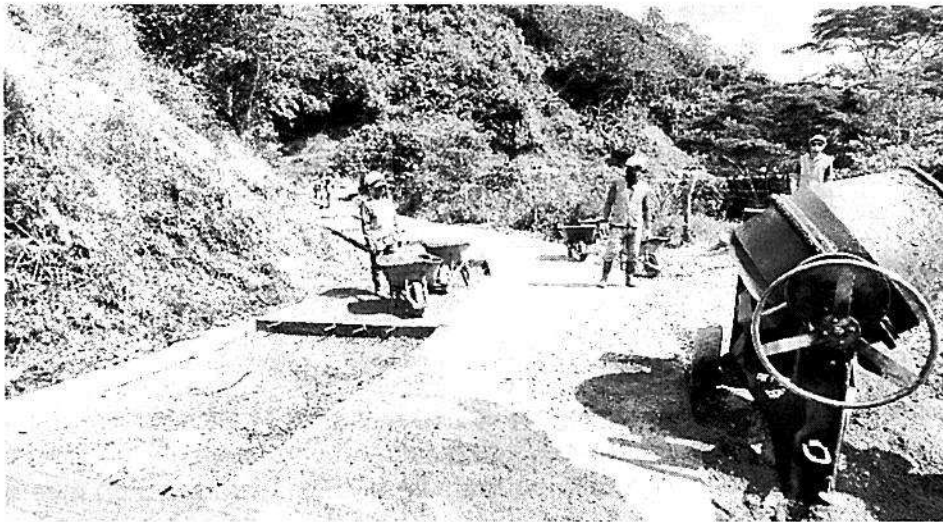
Construcción de concreto, para la intervención de la vía en el municipio de Giraldo.
