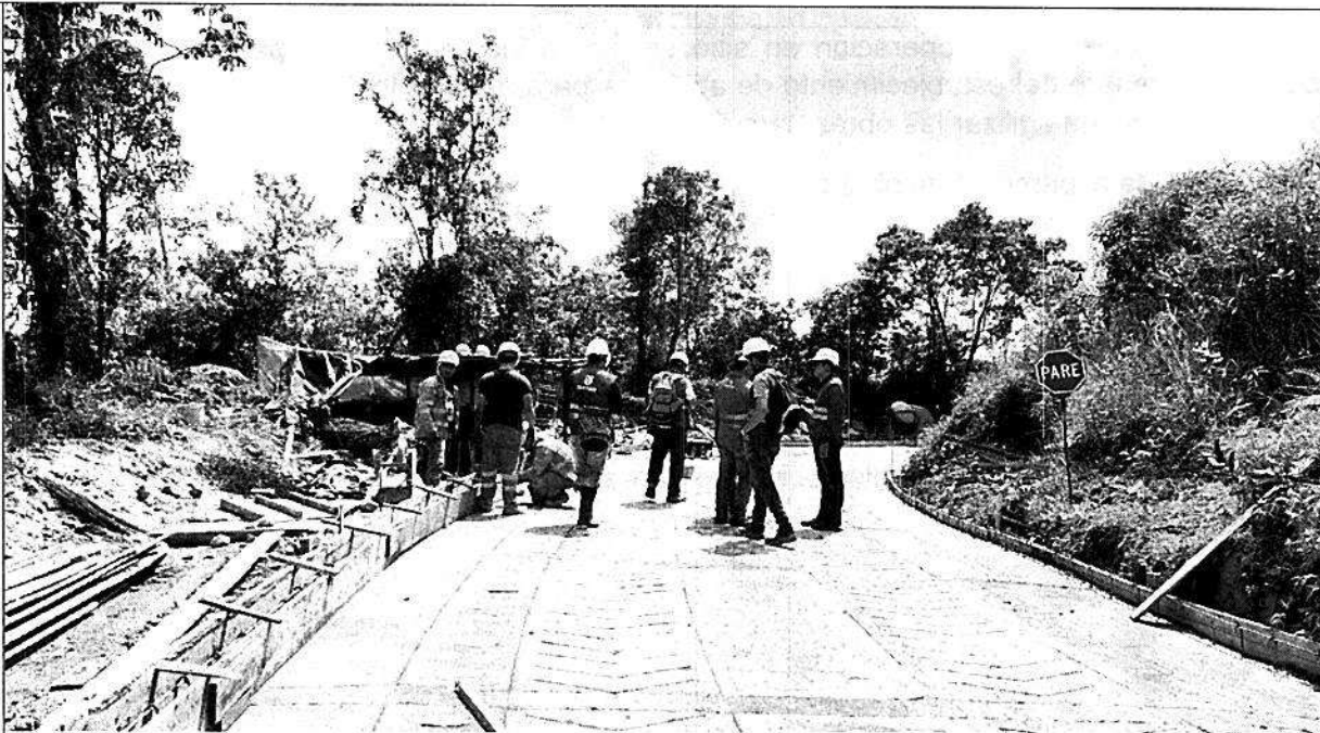
Placa Huella en ejecución, tramo en proceso de formaletería.
