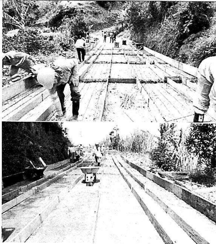
Formaleta para vaciado de placa huella.
