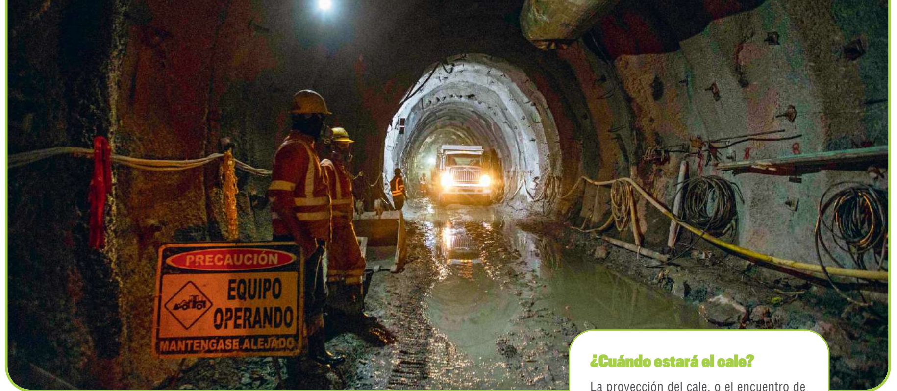
La galería de rescate es 100 metros más larga que el túnel principal.
