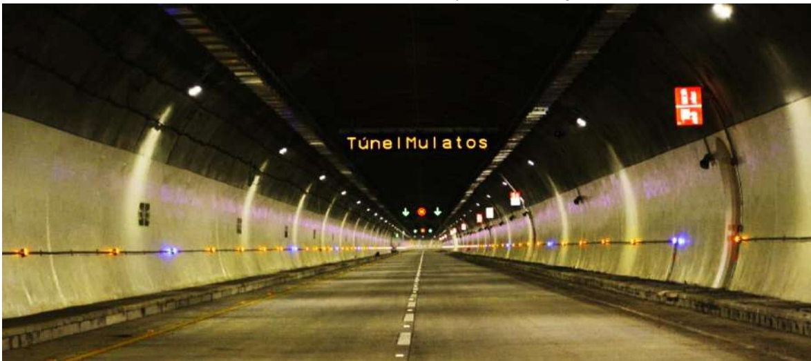
Figura 88. Túnel Mulatos. Elaboración propia, 2021
