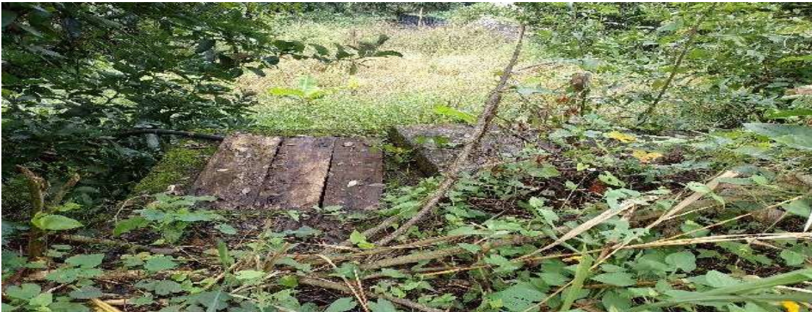
Figura 37. Rejilla y tanque de almacenamiento
