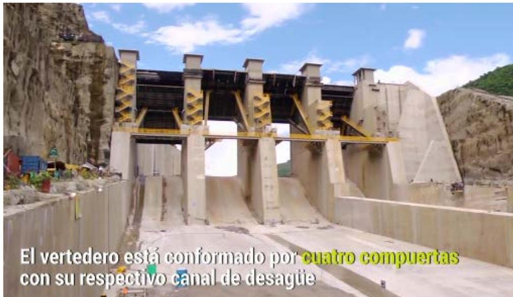
***Figura 51 EPM informó que en la tarde de este viernes fue construida la última losa de concreto del vertedero, con lo que se culmina esta parte del proyecto***
