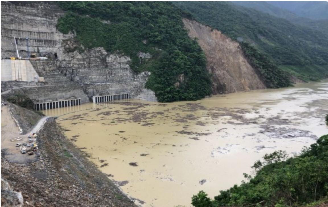
**Figura 45. Por las ventanas que se ven al fondo entra el agua represada a la casa de máquinas.**
